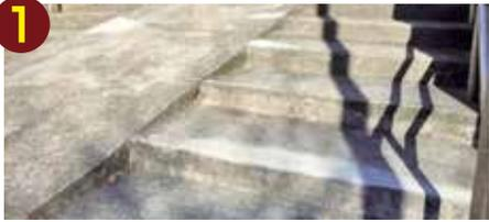
こちらは瀬ヶ崎小学校近くの階段。劣化して、ところどころコンクリートが剥がれ、欠けており、「のぼりづらい」「破片を踏んで滑った」などのお声を頂いていました。数か所の補修を行い、ひと安心です。
