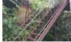
▲富岡西3丁目のガケ崩れ現場
