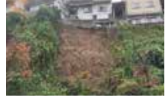
▲富岡西7丁目のガケ崩れ現場
