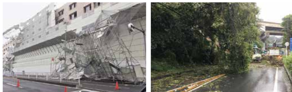
▲区役所前で解体中のビルの足場が崩落。国道16号線が一時通行止めに ▲朝比奈インター付近のがけ崩れにより、環状4号線も一時通行止めに
