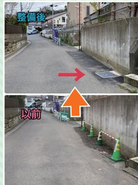
富岡東地域の住宅地。排水マスの老朽化で「雨天時には水があふれ、平時でも水が引かない状態です」とのご相談。排水マスの取替と周囲のアスファルトの擦り付けを行いました。
