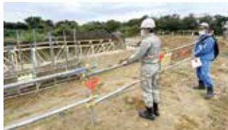
▲安全対策工事を進める現場を視察
