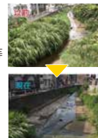
▲侍従川上流部 2019年2月に 土砂掘削等を実施
