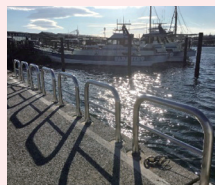
金沢漁港に設置された安全柵
