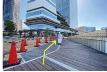
▲スターバックス方面へ通路を新設
