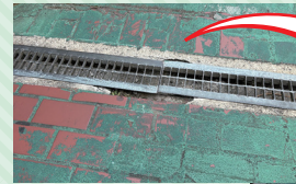
▲側溝のコンクリートが欠損
