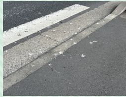
▲側溝のコンクリートが欠損
